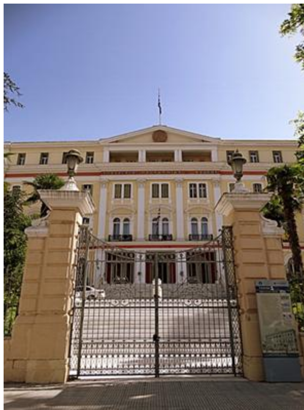
Εικόνα 4 : Νότια όψη του κτιρίου από κεντρική πύλη επί της οδού Αγίου Δημητρίου
