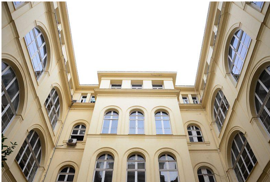
Εικόνα 4 : Εσωτερικό αίθριο του κτιρίου
